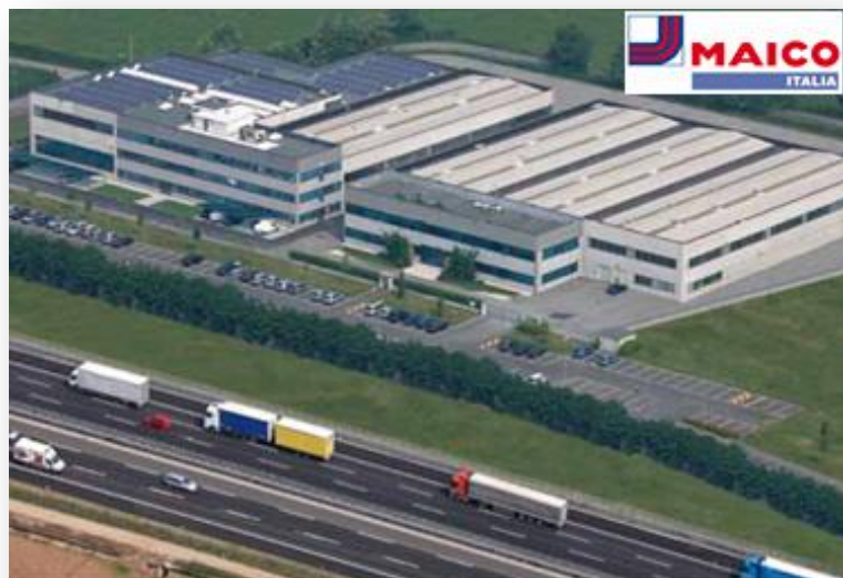
La nuova sede di Maico Italia SpA a Lonato del Garda (BS): l'impianto fotovoltaico da 65Kw copre il 50% dei fabbisogni energetici di Maico Italia.
