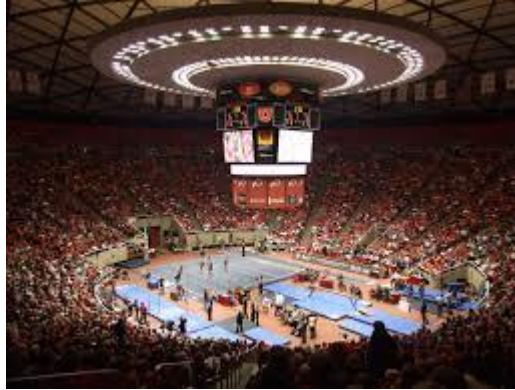
Immagine 5 – Impianto di diffusione sonora di tipo Speaker Cluster nel J. M. Huntsman Center, Salt Lake City, Utah.
